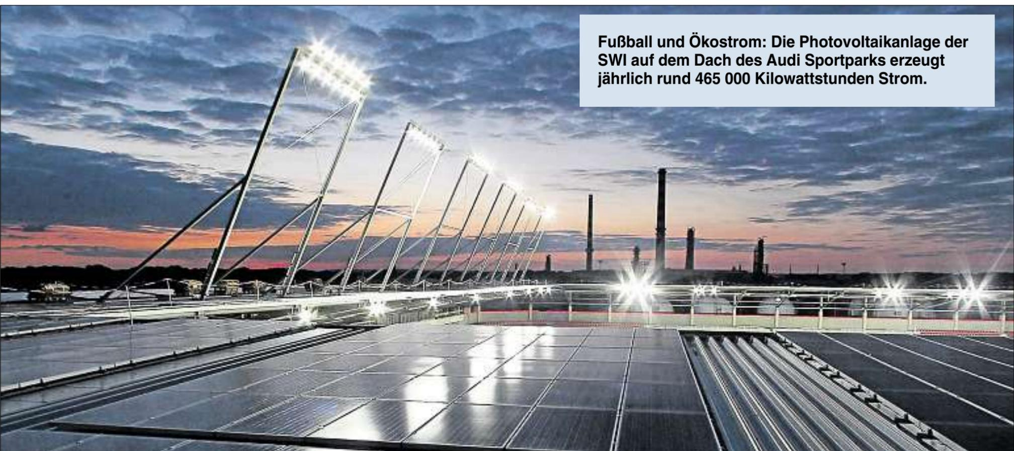
**Fußball und Ökostrom: Die Photovoltaikanlage der SWI auf dem Dach des Audi Sportparks erzeugt jährlich rund 465 000 Kilowattstunden Strom.**
