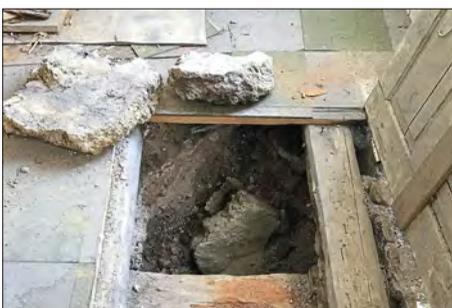
**ÖFFNUNGEN** Die Böden werden partiell geöffnet, um die tragenden Holzelemente zu untersuchen und zu bewerten.
