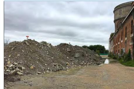
**BODENUNTERSUCHUNGEN** Der Boden wird auf Schadstoffe untersucht, und die Haufwerke lt. Belastungsklasse entsorgt.
